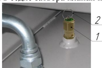
Рисунок 8 – Клапан предохранительный пружинного типа
