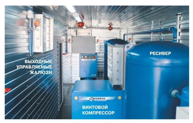
Применение модульных компрессорных станций, выполненных на базе 20-ти и 40-ка футовых железнодорожных контейнеров морского исполнения, по сравнению со станциями расположенными в капитальных зданиях, дает значительную экономию средств и времени, исключая затраты на строительство. По сравнению со станциями выполненными на базе кунгов - наиболее полное обеспечение оборудованием, повышенная безопасность и высокая степень автоматизации в управлении.
